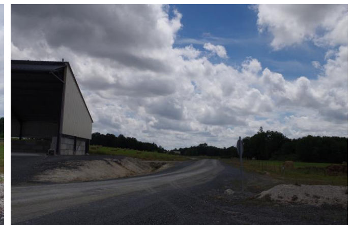
Photo 6 : Vue sur le chemin d'accès, la prairie et les bâtiments de la carrière
